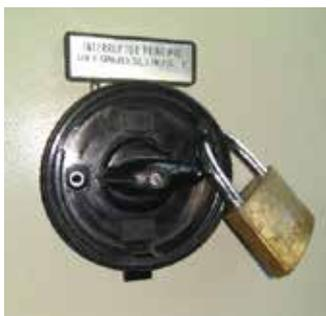
Figura 6. Bloqueo de un seccionador mediante candado.
