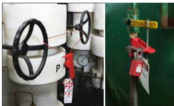
Figura 9. Bloqueo de válvulas (Brady) con LOTO.
