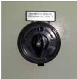
Figura 2. Interruptor seccionador.
