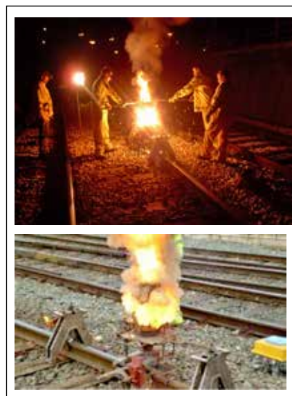
Figura 9. Reacción durante la soldadura aluminotérmica.
