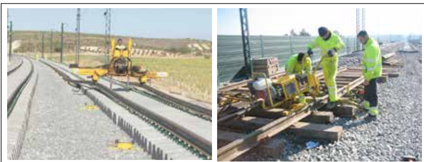
Figura 4. Posicionado y apriete del carril.
