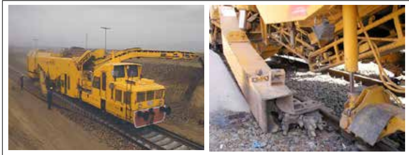
Figura 11. Desguarnecido de la vía.
