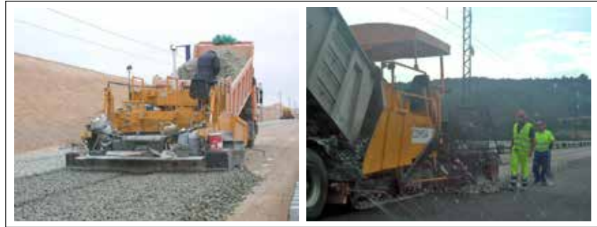
Figura 2. Actividad de extendido del balasto.
