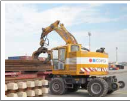
Figura 10. Retroexcavadora ferroviaria manipulando el carril.
