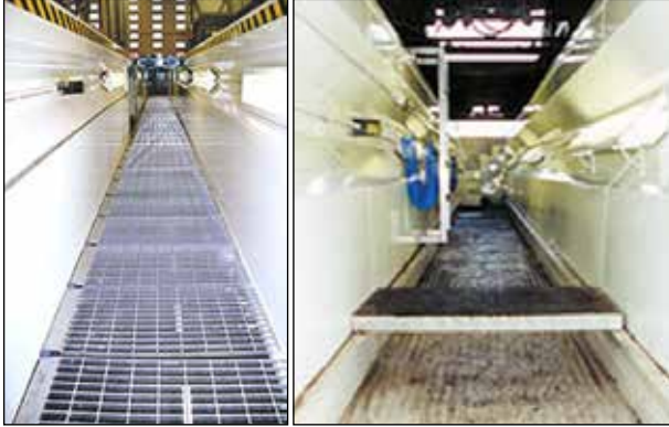
Figura 8. Superficie del foso de plancha perforada antideslizante.
