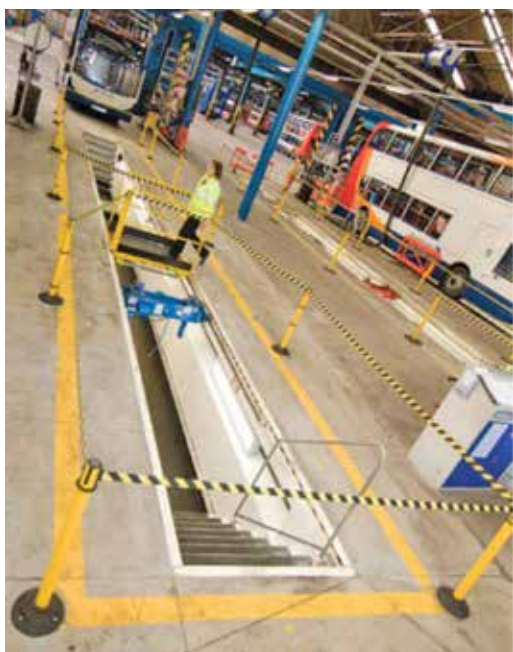
Figura 6. Pasarela de paso o de trabajo sobre el foso.
