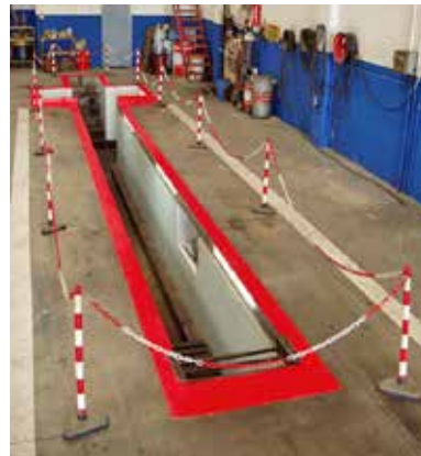
Figura 4. Zona de acceso al foso delimitada con barreras.
