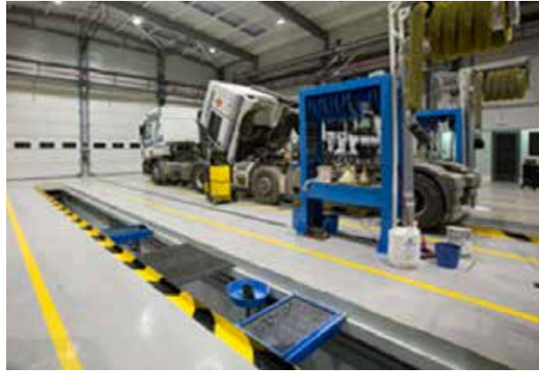
Figura 10. Vista de los dos perfiles de protección en "L" laterales.
