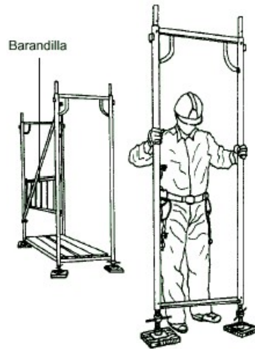
Figura 11. Colocación de las barandillas y posicionamiento del siguiente suplemento
