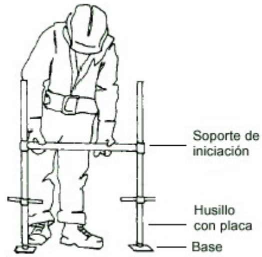
Figura 6. Introducción del soporte de iniciación en los husillos con placa
