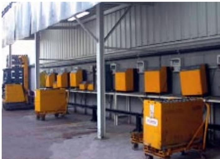
**Figura 1. Local destinado a la carga de baterías (cortesía de YORKA, SA)**
