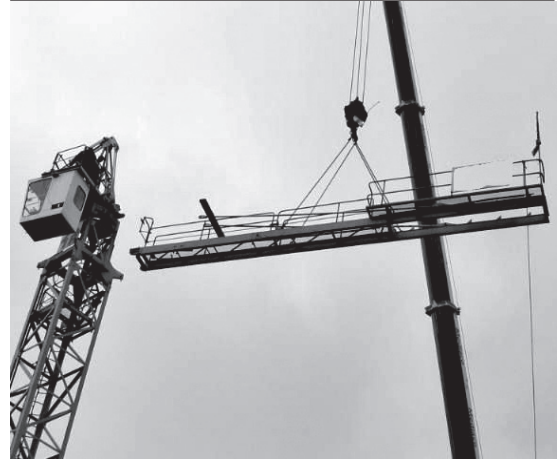
Figura 14. Guiado de la carga
