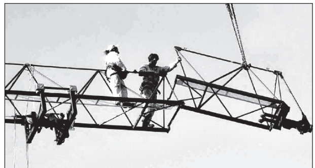
Figura 21. Montadores sujetos con EPI a la estructura
