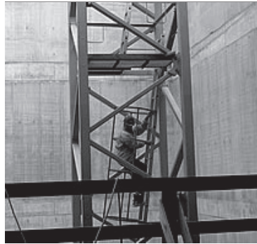
Figura 17. Escala de acceso protegida
