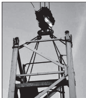
Figura 7. Eslingado correcto de componentes alargados
