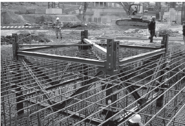
Figura 1. Fundación de la grúa según proyecto y nivelada
