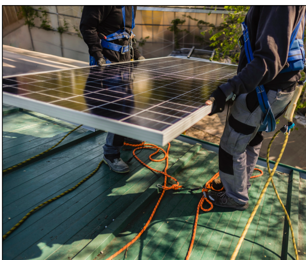
Figura 10. Utilización de línea de anclaje horizontal con un equipo de amarre y absorbedor de energía integrado en colocación de placas solares.
