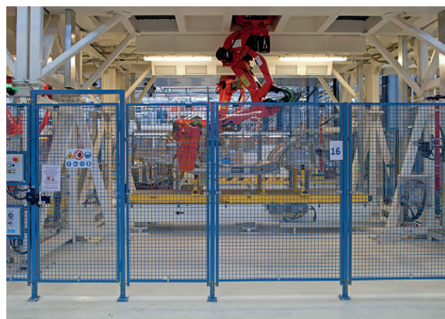
Figura 3. Resguardo fijo distanciador empleado como protección perimetral. 73
