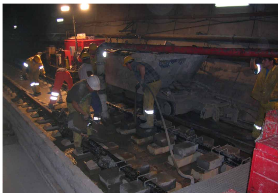
Ilustración 1. Hormigonado en vía ferroviaria.
