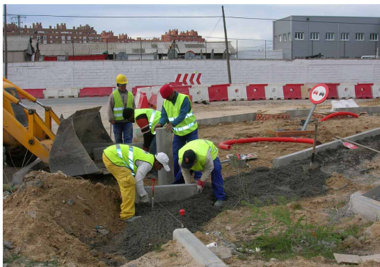
Ilustración 2. Postura forzada durante la instalación de bordillo.
