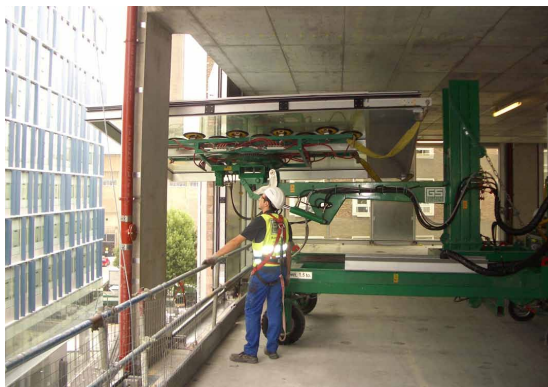
Ilustración 12. Instalación de muro cortina mediante sistemas automáticos de manipulación por vacío.
