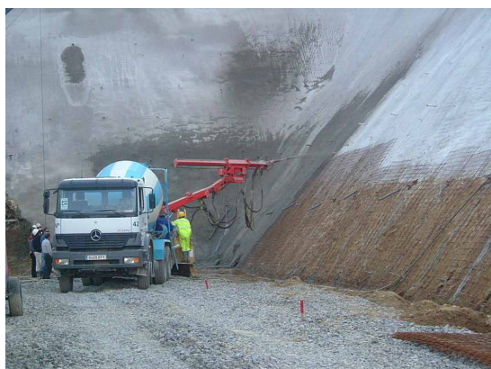
Ilustración 10. Gunitado de talud.
