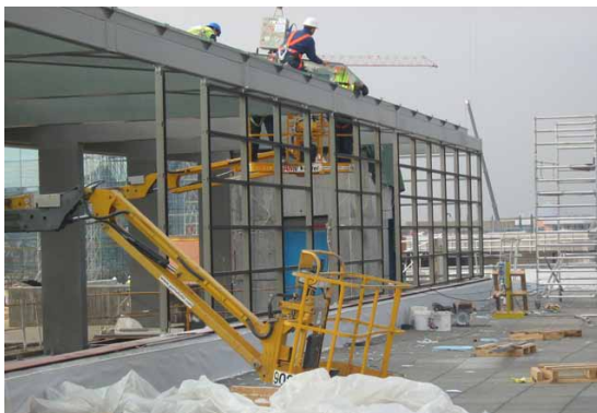
Ilustración 4. Instalación de cubierta acristalada.
