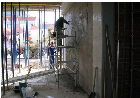
Ilustración 4. Enyesado de tabique.
