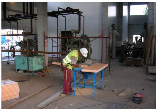
Ilustración 8. Corte de madera mediante sierra circular.
