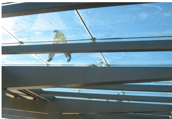
Ilustración 3. Tránsito por cubierta acristalada.
