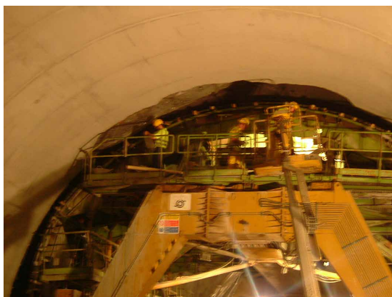
Ilustración 2. Trabajos de revestimiento de túnel.
