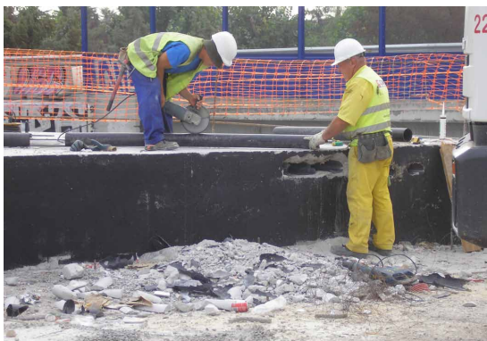
Ilustración 6. Corte de tubo mediante sierra circular.
