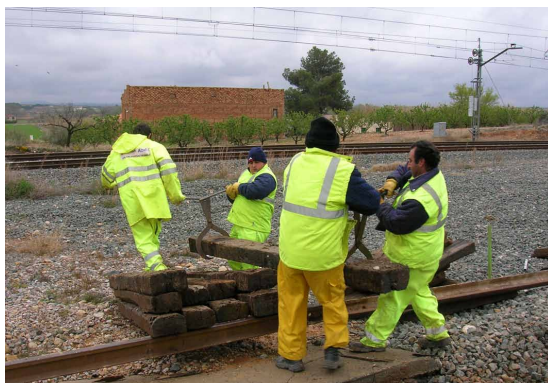
Ilustración 7. Manipulación de traviesa mediante pinzas manuales.
