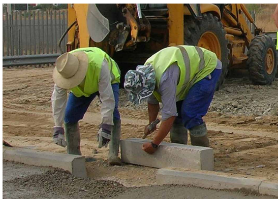
Ilustración 1. Instalación de bordillos de hormigón.
