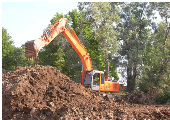
Ilustración 11. Movimiento de tierras mediante retroexcavadora.
