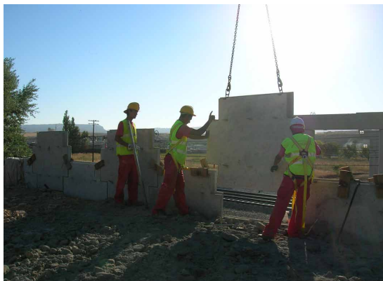
Ilustración 3. Instalación de paneles de tierra armada.
