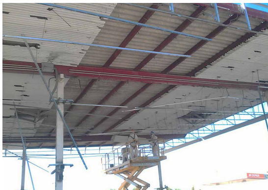
Ilustración 9. Retirada de amianto.
