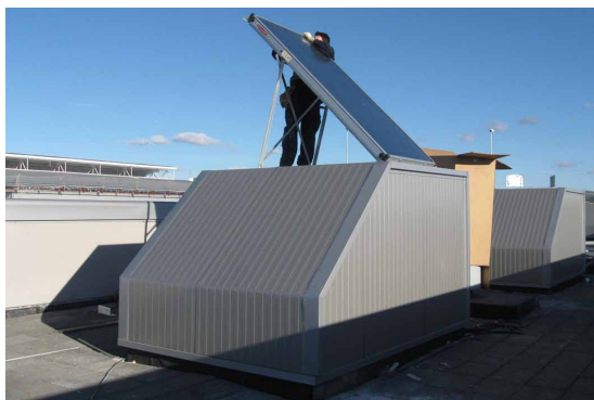
Ilustración 5. Instalación de panel solar en cubiertas.
