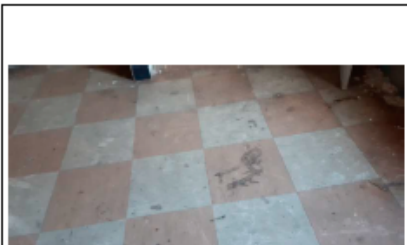
Prélèvement - P004 : BÂTIMENT ANNEXE LE CORBUSIER / RDC / LOCAL 0004 - Dalle de sol- (Absence d'amiante)
