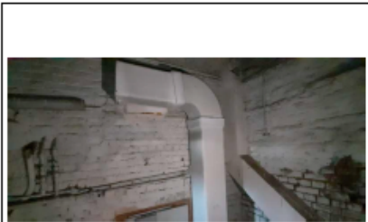
Prélèvement - P002 : BÂTIMENT ANNEXE LE CORBUSIER / SOUS-SOL / LOCAL S011 - Conduit - EP- (Présence d'amiante)
