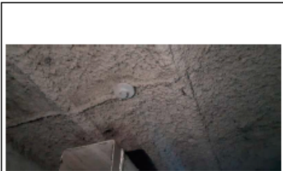
Prélèvement - P001 : BÂTIMENT ANNEXE LE CORBUSIER / SOUS-SOL / LOCAL S011 - Flocage- (Absence d'amiante)
