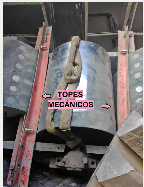
Figura 2: Parte superior del elevador de cangilones. Ejemplo del proceso de montaje de dos topes mecánicos (barras rojas) colocados sobre la propia estructura del elevador, cuya misión es sujetar las bandas del elevador de cangilones (previamente cortadas) e impedir el movimiento inesperado del conjunto a causa de la propia gravedad
