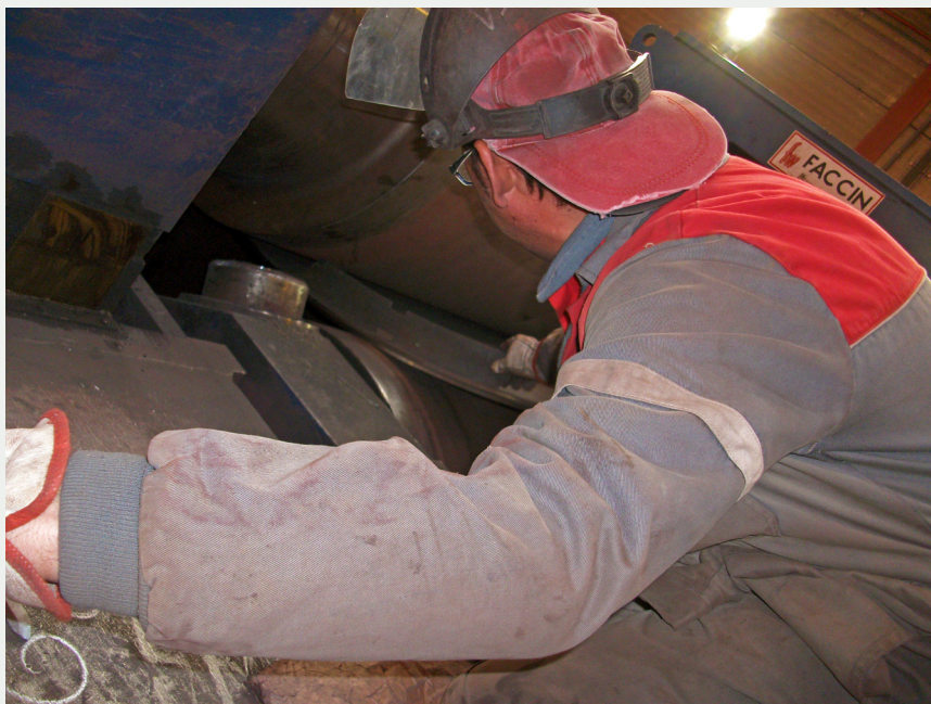
Figura 2: Operario realizando tareas de comprobación de curvatura con una galga
