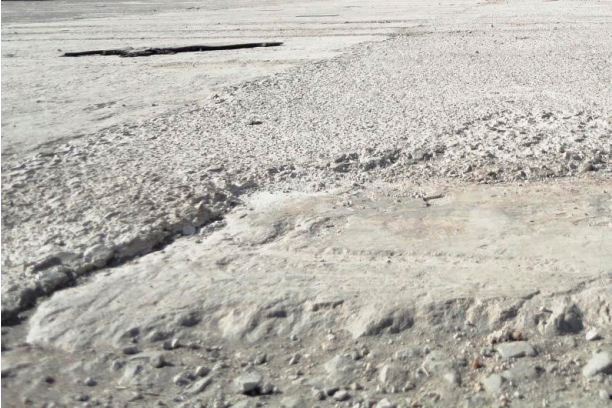
Figura 2: Terreno en mal estado
