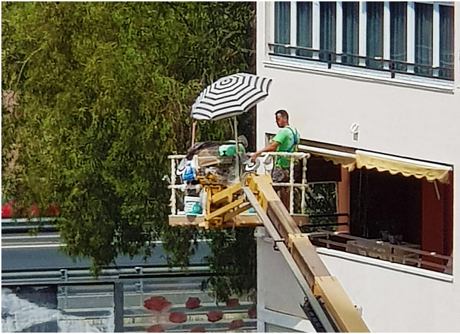
Figura 2: Plataforma utilizada como montacargas
