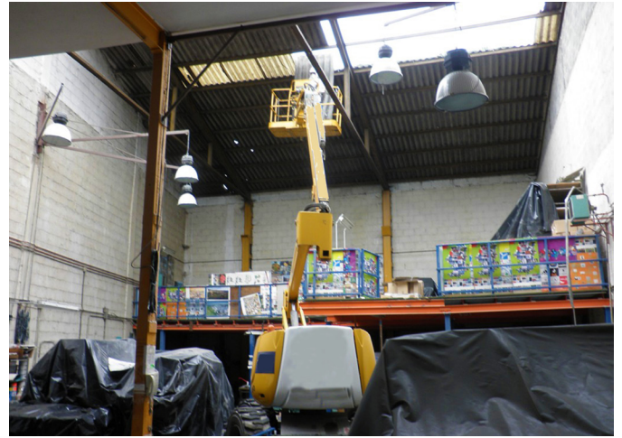
Figura 3: Plataforma elevada cargando material
