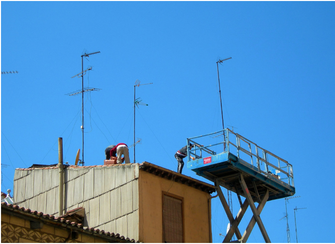
Figura 2: Plataforma utilizada como medio de acceso
