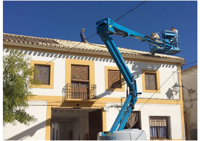
Figura 3: Acceso a tejado utilizando una plataforma
