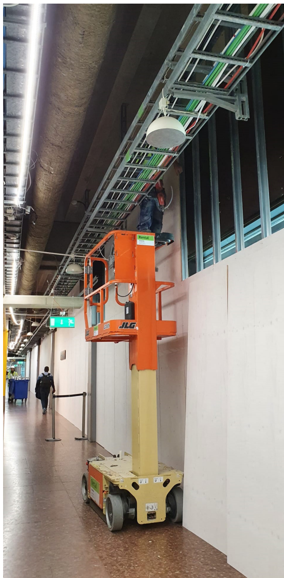
Figura 2: Trabajo en altura utilizando elementos auxiliares
