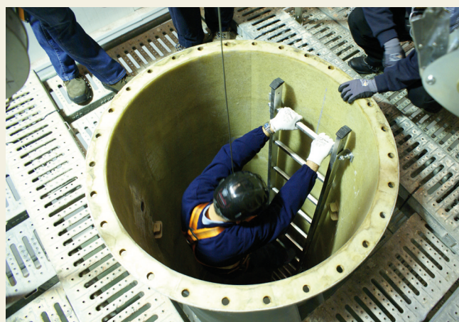
Acceso a un espacio confinado
