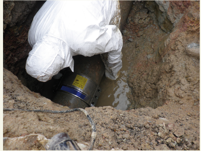
Colocación de abrazadera
