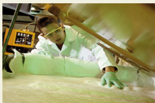
Inyección de resina
