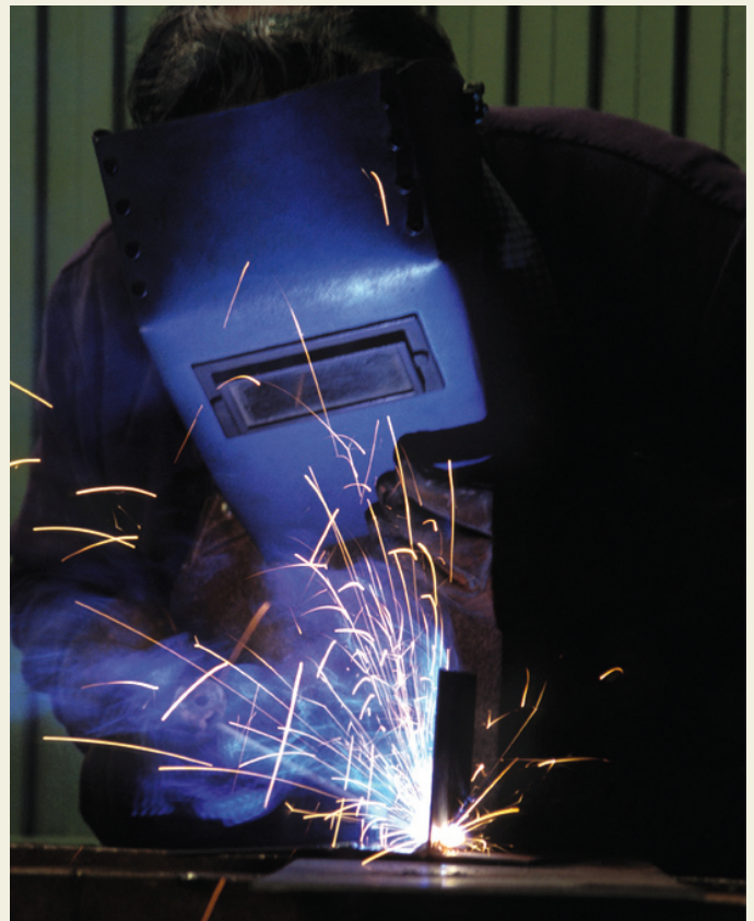
Soldadura manual al arco
