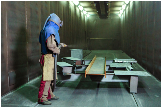
Figura 3: Tareas de chorroado en sala
