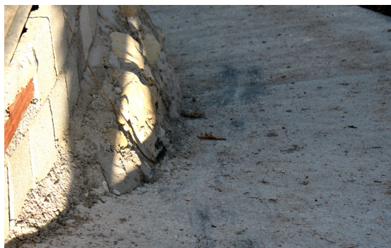
Figura 1: Marcas de contacto de la rueda trasera izquierda en el saliente de la pared. En este punto se produce un cambio en la trayectoria del vehículo
