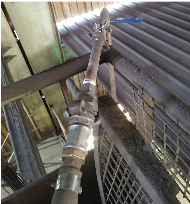
Figura 1: Elementos colocados por el trabajador para conectar martillo neumático, llave de paso, racor tipo Barcelona y manguera de alimentación
