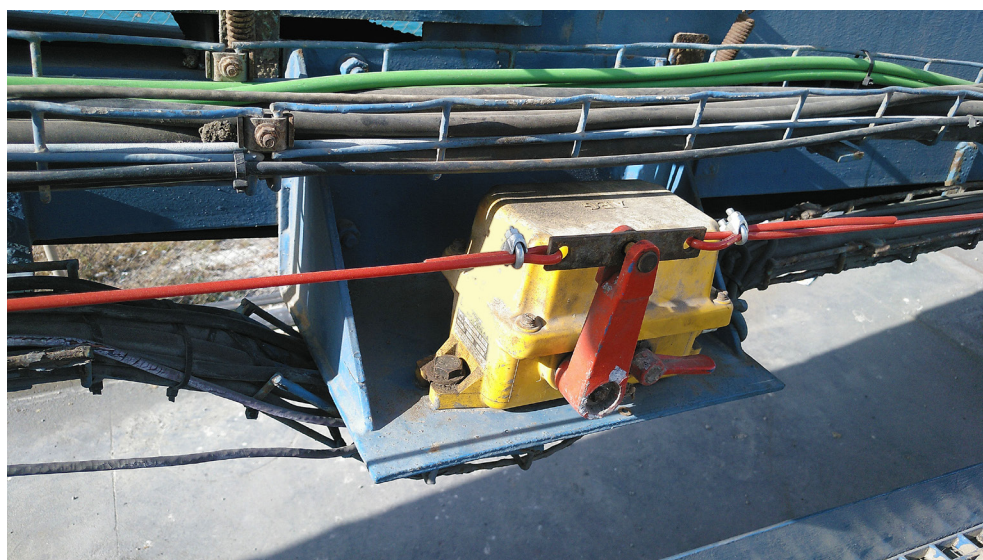
Figura 4: Botón de parada de emergencia tipo seta
