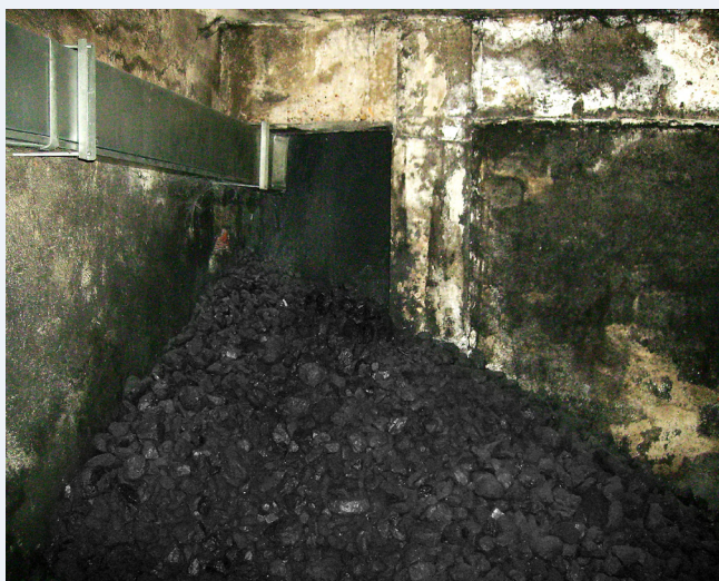
Figura 1. Tronera para vertido de carbón y única vía de ventilación.
