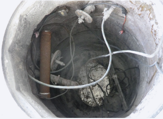
Imagen 2. Boca de acceso al depósito
