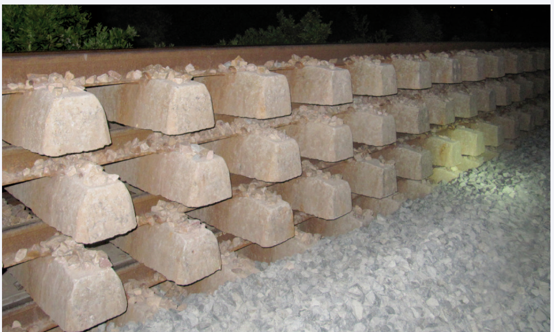
Acopio de parejas
