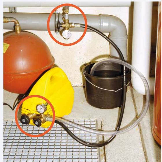
En la figura de la derecha se puede ver una imagen de la bomba eléctrica de llenado que dispone de un manómetro en el que ajustar la presión deseada y existe otro manómetro en la conexión al circuito.
