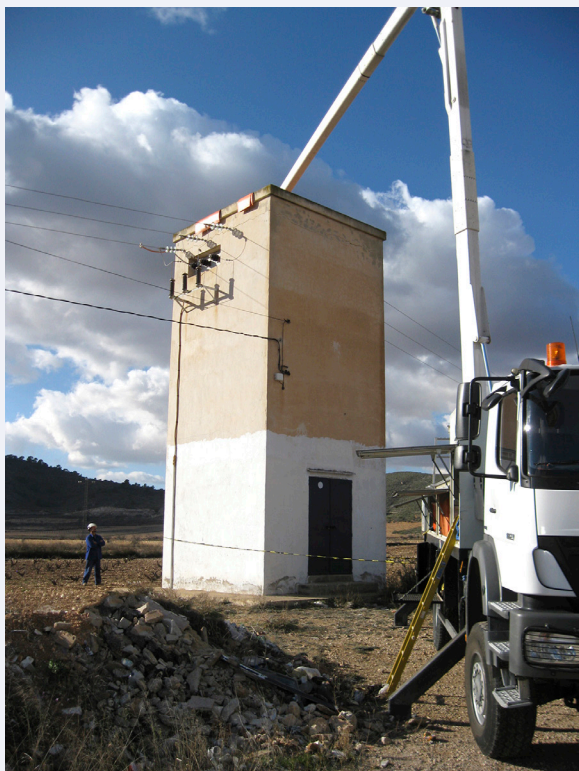
Vista exterior del centro de seccionamiento y medición
