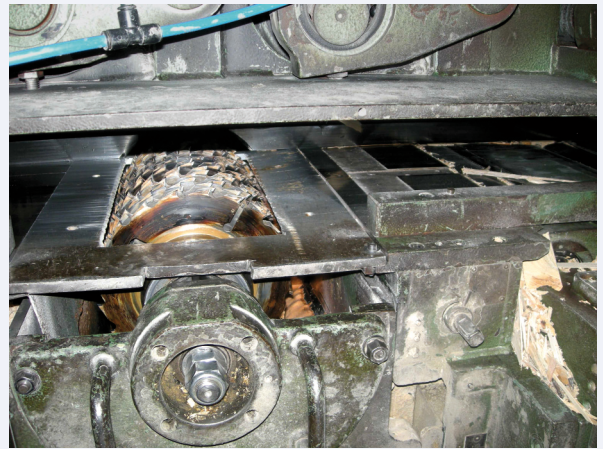
Detalle del tambor de la sierra múltiple donde ocurrió el accidente
