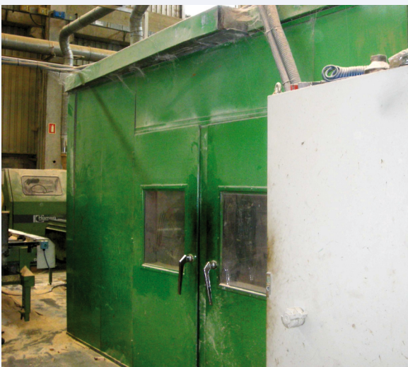
la cabina cerrada
