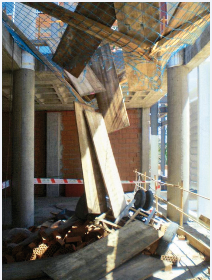
Rotura de la red y transpaleta y ladrillos sobre los que cayeron los trabajadores
