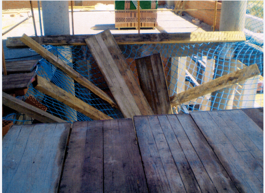
Superficie que colapsó sobre la que estaban subidos los trabajadores
