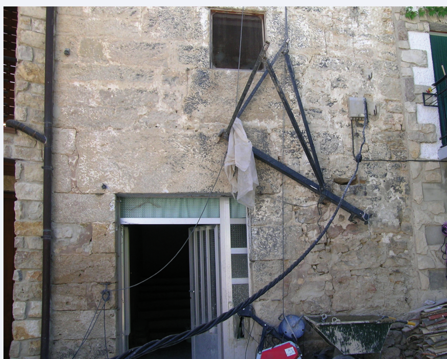
Estado en el que quedó la zona tras el accidente
