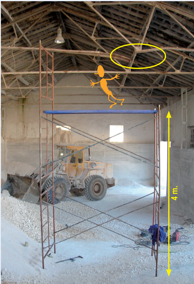
Vista del andamio montado y del corte realizado en la cercha a reparar
