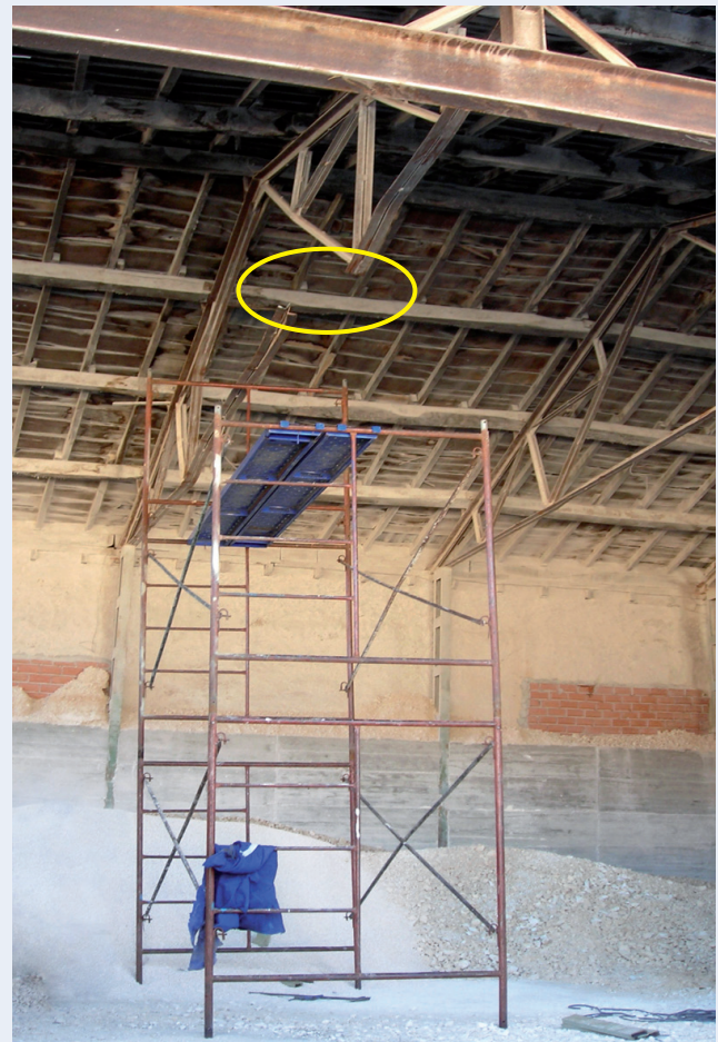
Vista del andamio montado y del corte realizado en la cercha a reparar
