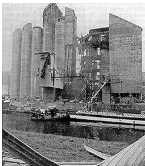
Fig. 1: Efectos de la explosión de polvo en un silo de maíz (Foto: P. Janssens)
