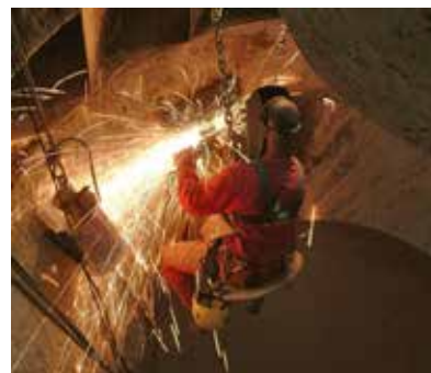
Figura 12. Trabajadores protegidos del riesgo de proyección de partículas.
