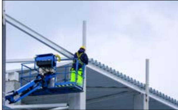
Figura 4. Ejemplo de trabajo en plataforma elevadora.
