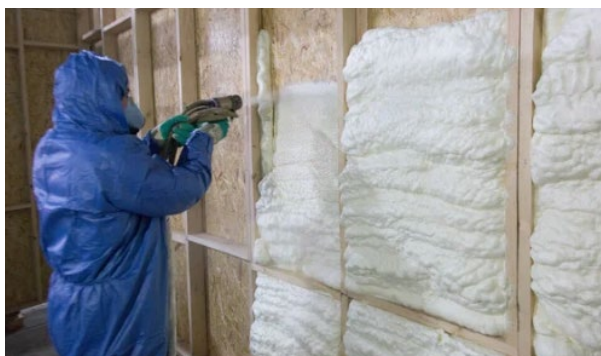
Imagen 1: Aplicación de aislante de espuma de poliuretano.
