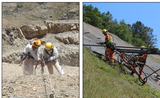
Figura 7. Trabajos realizados en taludes utilizando sistemas de sujeción. Fotografías propiedad de Desnivel Agraraltura, S.A.
