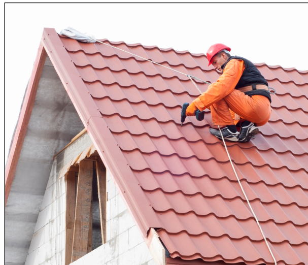
Figura 5. Trabajos sobre planos inclinados.
