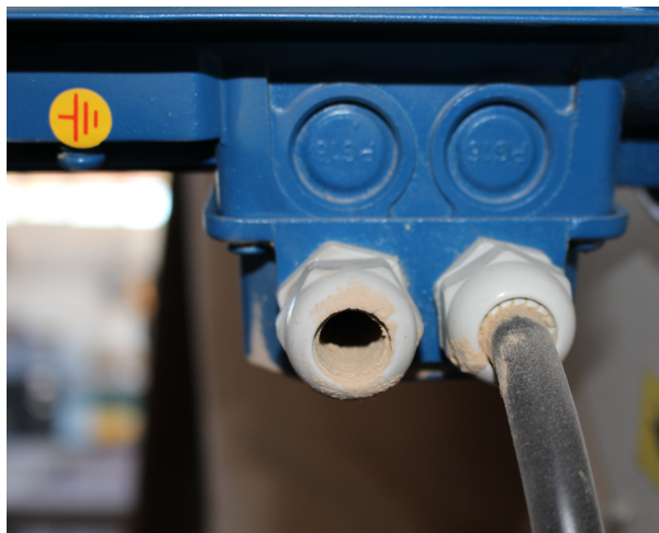
Figura 2. Imagen de acumulación de polvo en entrada de prensaestopas.
