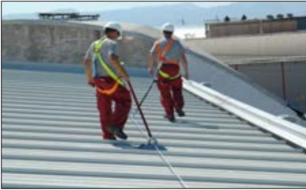
Figura 3. Ejemplo de trabajo cerca de borde de forjado. Fotografía propiedad de MultiGarBen.
