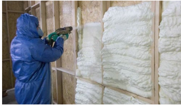
Imagen 1: Aplicación de aislante de espuma de poliuretano.
