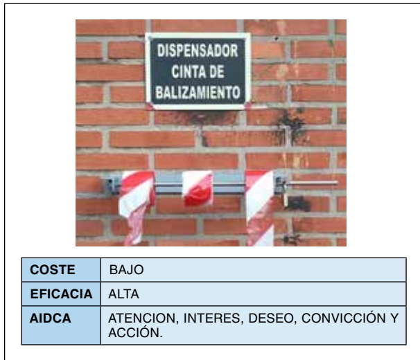
Figura 14. Sugerencia de mejora sobre dispensador de cinta de balizamiento.
