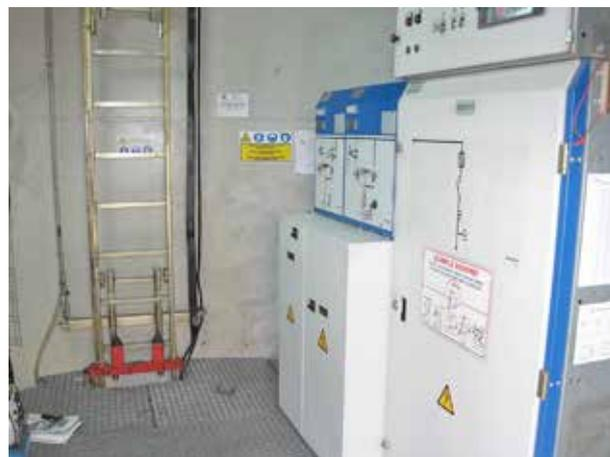
Figura 3. Celdas de alta tensión en la base.
