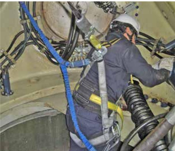
Figura 8. Trabajo en el interior del buje.
