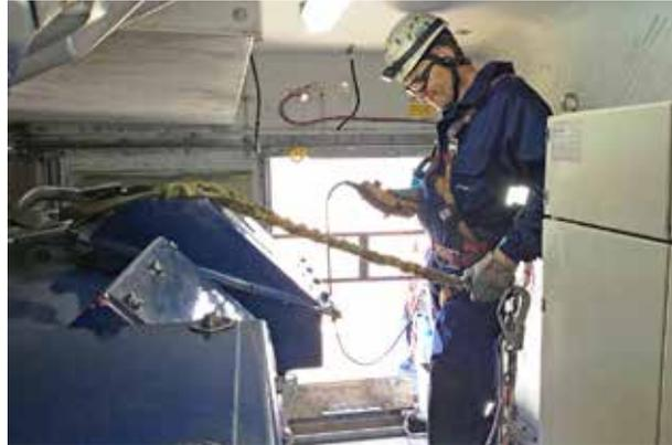
Figura 1. Puerta trasera en la nacelle con polipasto.
