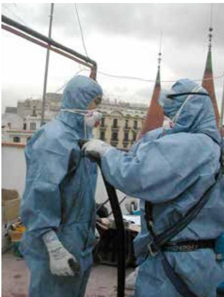
Figura 1. Aspiración previa a la descontaminación en cabina.
