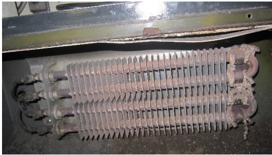
Aislamiento de resistencias en mal estado
