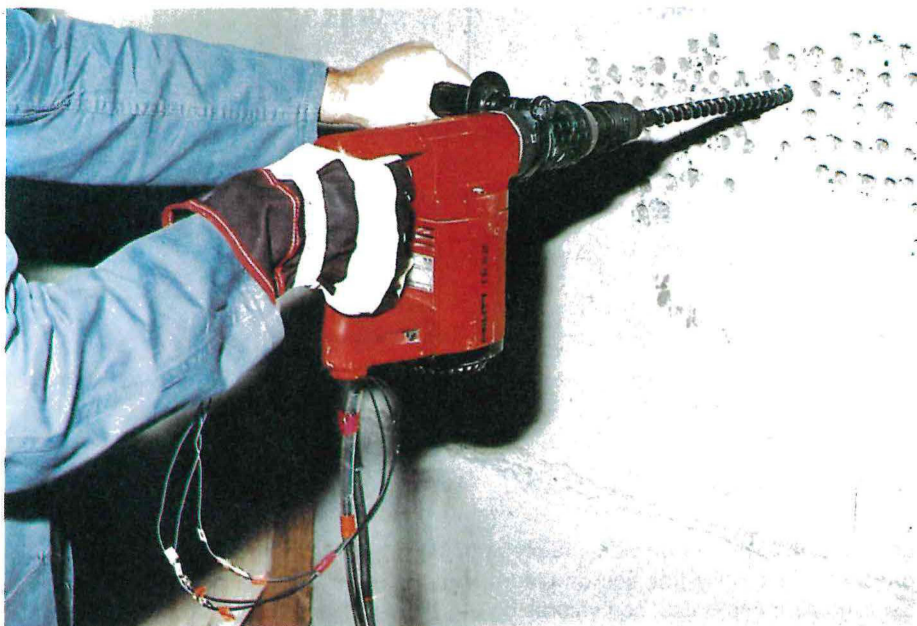
Figura 5.5: La utilización de taladros de martillo como alternativa a los taladros de pistón, disminuye la exposición a vibraciones y la emisión de ruido.
