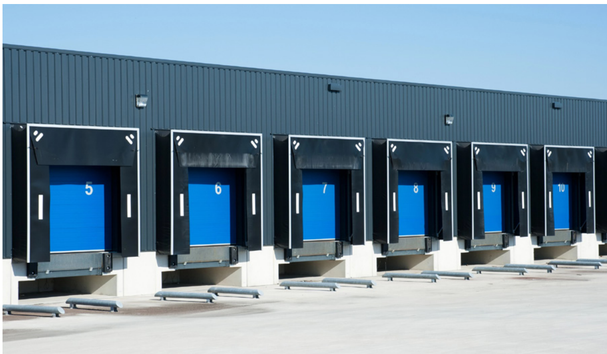
Muelles de carga con abrigos y guías de rueda sobre el suelo |
