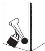
Figura 19 Interruptor general de la grúa consignado
