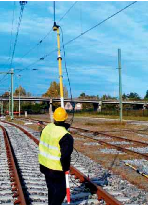
Figura 6: Operaciones de desconexión eléctrica de una instalación ferroviaria.
