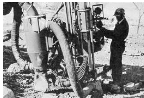
Fig. 8: Cámara de expansión separada del sistema de filtrado
