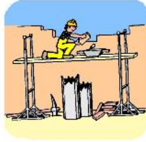
Fig. 11: Falta de orden y limpieza
