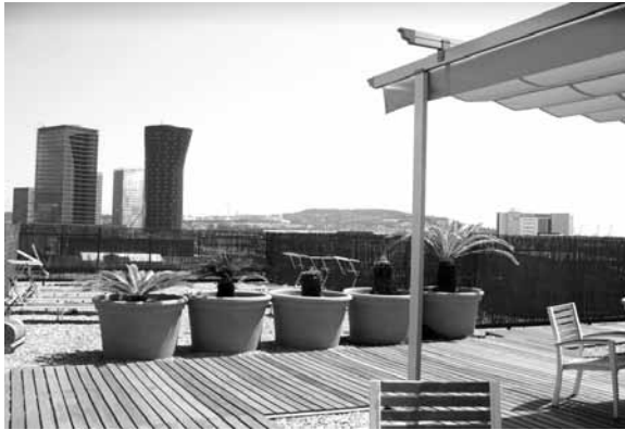
a) Cubierta transitable como lugar de descanso.
