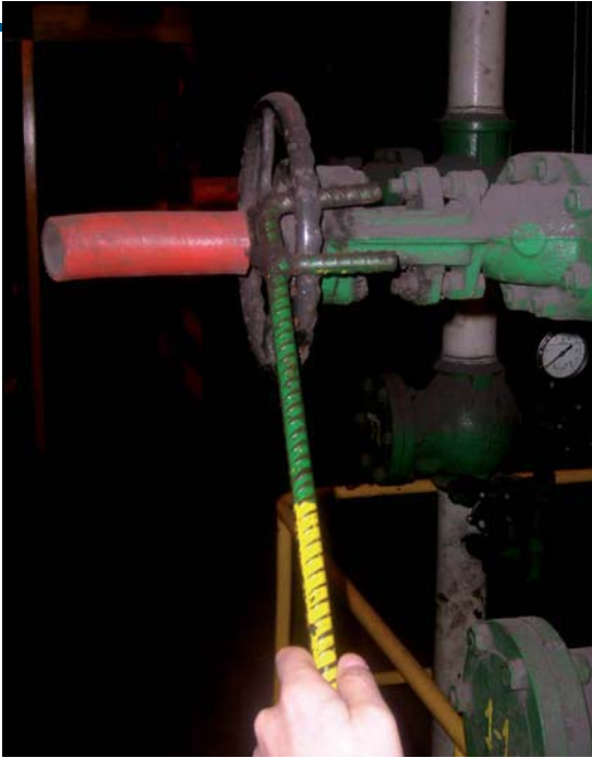
Fig. 1 Útil empleado en la apertura y cierre de válvulas de volante.
