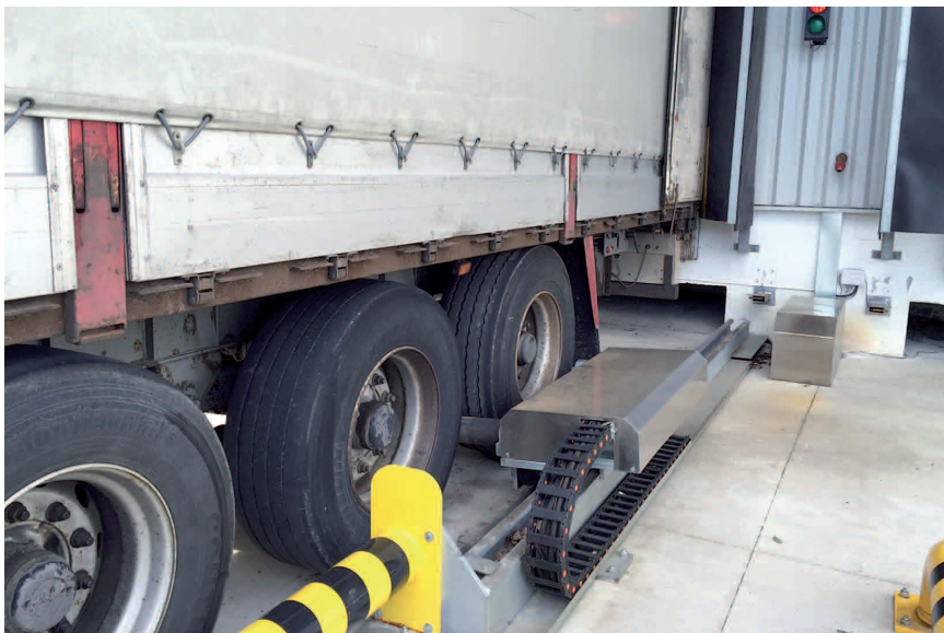
Sistema de bloqueo que automatiza todo el proceso de aproximación al muelle
